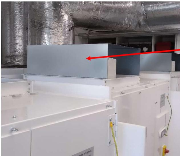
Protection du Bioxigen à enlever avant d'installer le plenum ou avant la mise en place de la gaine
