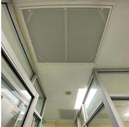
Description : Caisson permettant de diffuser ou d'aspirer l'air dans le local à traiter. Peut être équipé d'un registre et/ou d'un filtre.
